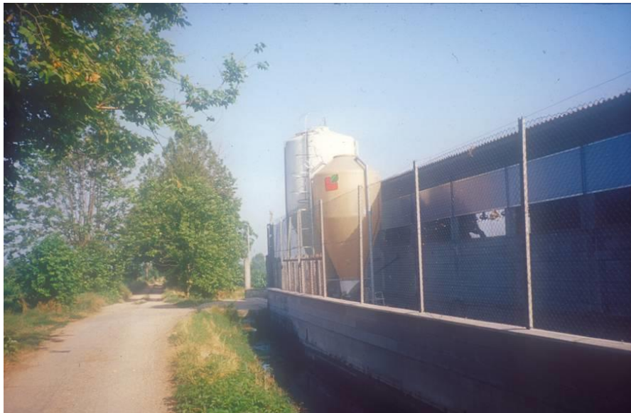
Figura 10b Silos posizionati sul lato a caricamento esterno dalla recinzione continua intorno all'allevamento
