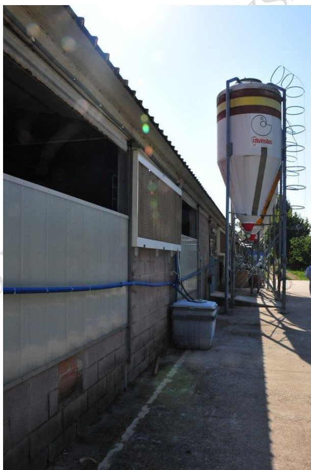
Figura 10a Area dei silos correttamente gestita, libera da oggetti e sporcizia
