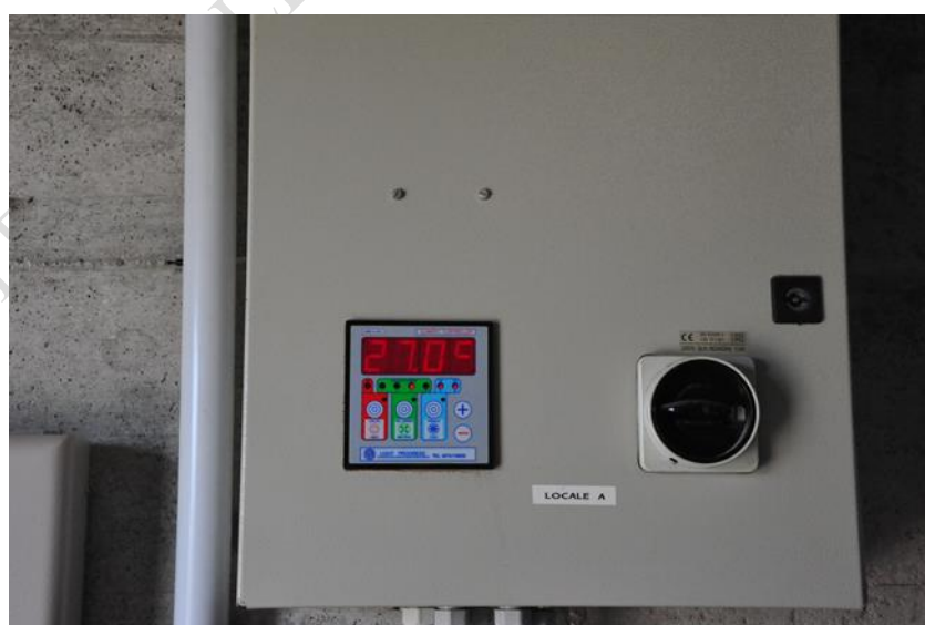
Figura 6 Impianto di regolazione temperatura ambientale
